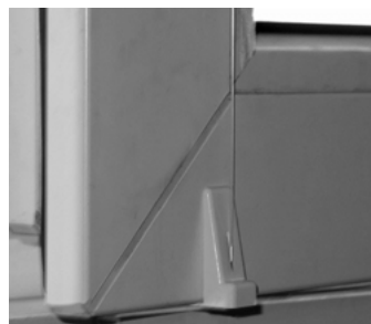
Рис.4 Установленный кронштейн в сборе
