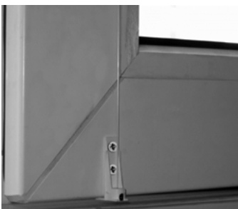
Рис.3 Установленный кронштейн без крышки
