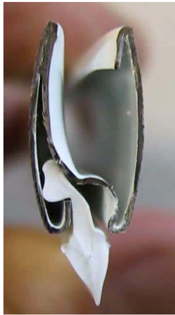
Рис. Вставка уплотнителя в нижнюю планку
