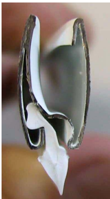
Рис. Вставка уплотнителя в нижнюю планку
