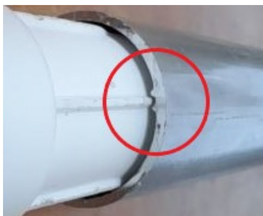
Рис. Установка механизма управления и боковой заглушки на трубу
